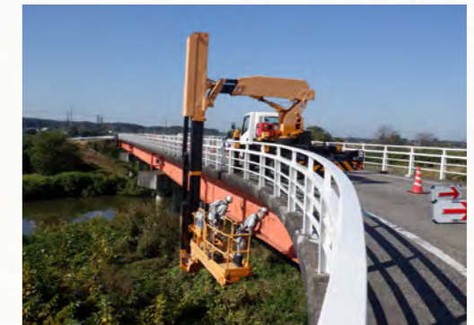
水神橋 (橋梁定期点検業務:土浦市)
