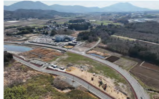
(仮称) 大和駅北公園 公園整備工事 (積算業務:桜川市)
