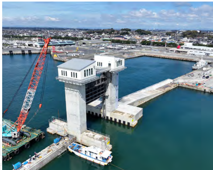
茨城港大洗工区海岸 水門ゲート据付工事 (積算・工事監督補助業務：茨城港湾事務所大洗工区事業所)
