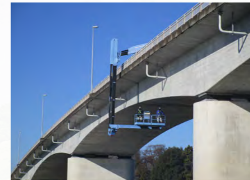
常総きぬ大橋 (橋梁定期点検業務:常総市)
