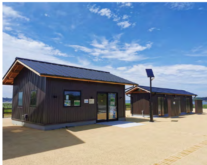
洞沼野鳥公園管理棟・トイレ棟建築工事 (積算・工事監理業務：鉾田市生活環境課)
