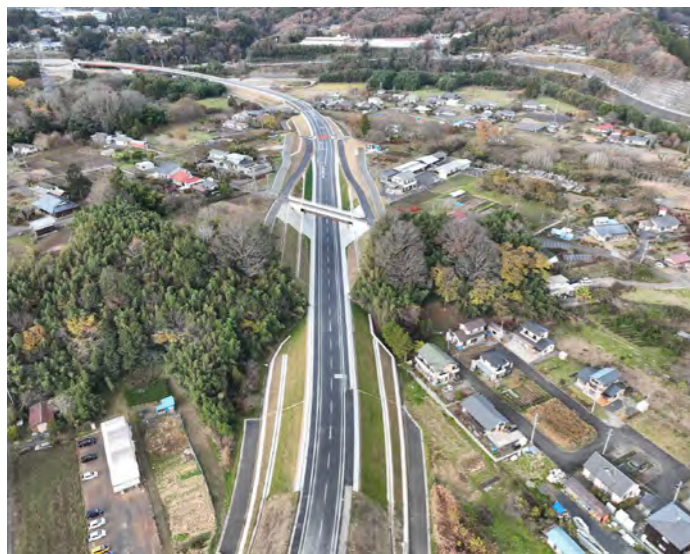
一般国道118号 袋田バイパス 道路改良舗装工事 (積算・工事監督補助業務：茨城県常陸大宮土木事務所大子工務所)
